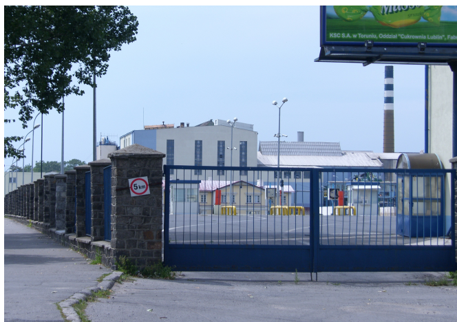
Fot. 9 Zlikwidowana „Cukrownia Lublin”
