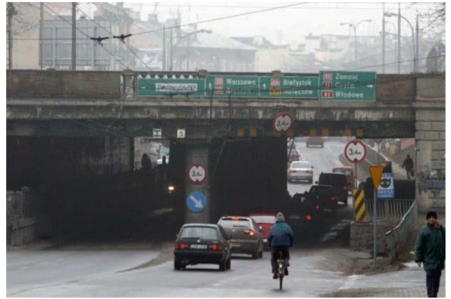
Fot. 20 Wiadukt kolejowy, ul. Kunickiego, obecnie
