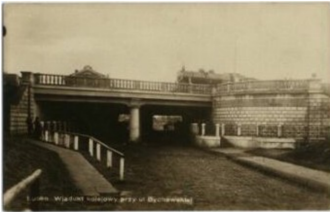
Fot. 19 Wiadukt kolejowy ul. Kunickiego , lata 30-te XX w.
