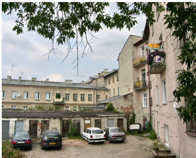
Fot.9 Zabudowa ul. Dworcowej
