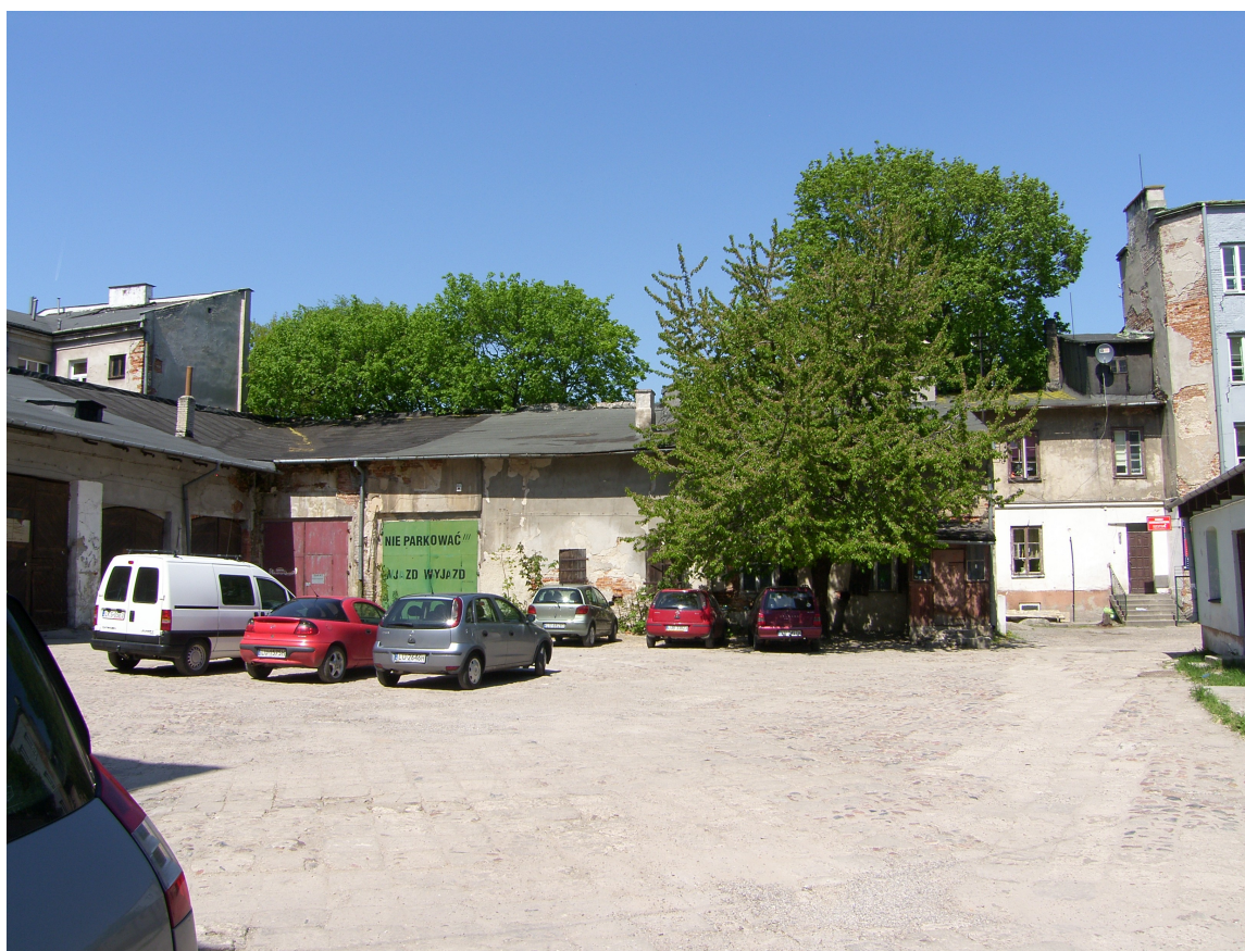
Fot. 12 Centralna część omawianego kwartału z oficynami przedwojennego Hotelu „Victoria”.
